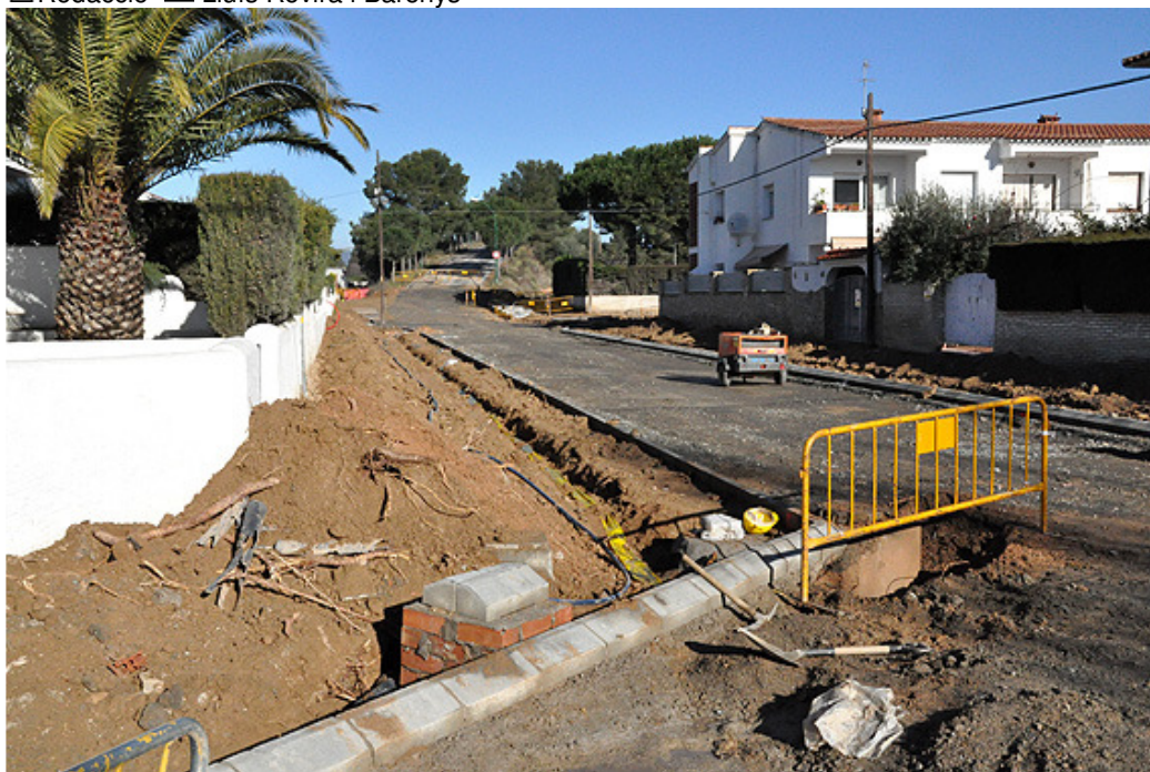
Imatge d'arxiu de la primera fase de les obres al barri
