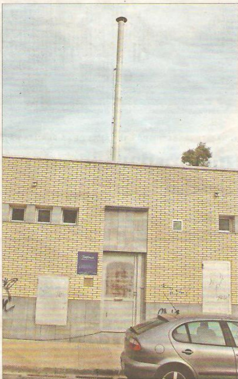
► En la esquina de la calle Joan Rebull con el Vial del Cavet existe una caseta de la firma Telefónica que ahora luce una chimenea. FOTO: JORDI CABRÉ
